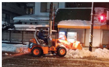
市内業者による除雪作業（2018年1月、橋本駅前）
