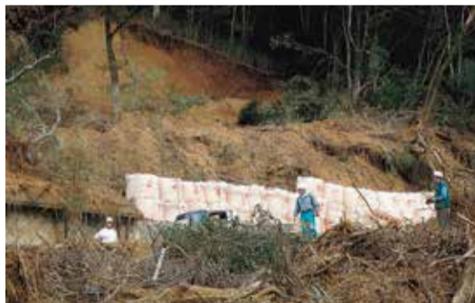
令和元年東日本台風で発生した土砂崩れ (藤野地区)
